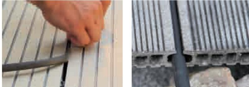
Für einen spaltfreien und blickdichten Boden **Fugenschlauch von oben eindrücken.**
