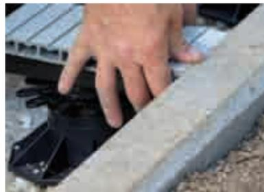
**Drainage:** 10 cm verdichtete Drainage (Kies/Splitt) einbringen. Je gerader und glatter der Untergrund um so leichter die Verlegung. Vorhandene Terrassenplatten lassen sich überbauen.
